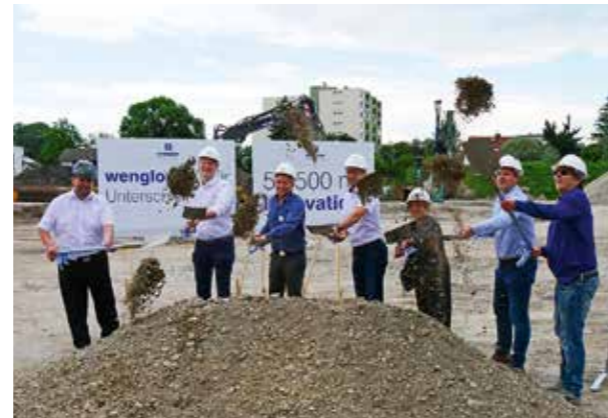
Spatenstich für die Innovation: Wenglor baut im Gewerbegebiet
